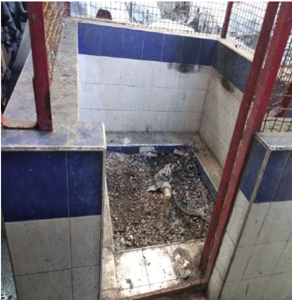
Fotografía 4. Estado actual del pozo.
