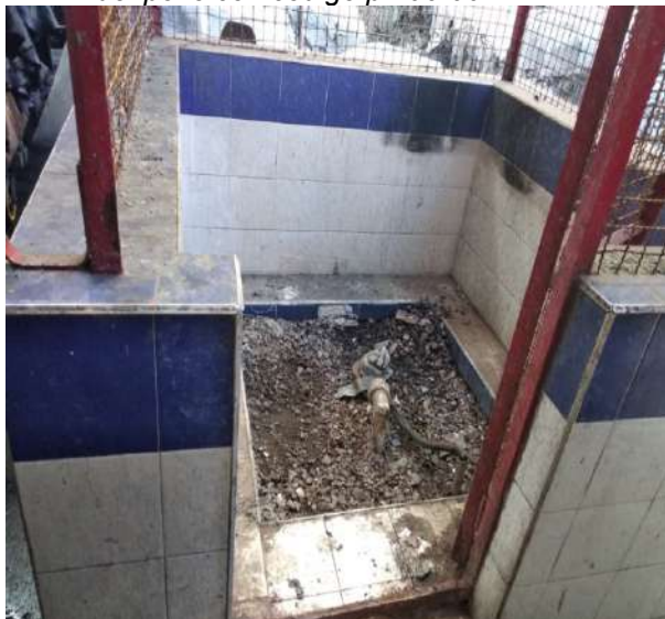
Fotografía 4. Estado actual del pozo.
