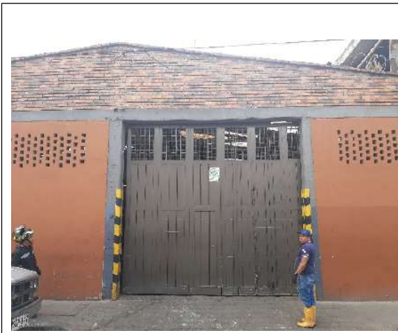
Foto No. 1. Fachada del predio.
