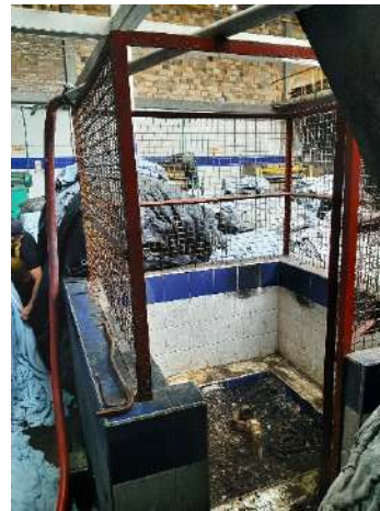
Foto No. 2. Vista general del pozo pz-06-0012
